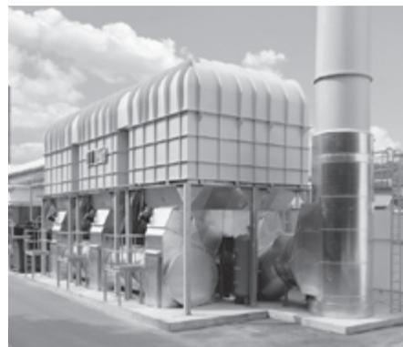
*Installation de post-combustion pour l'épuration thermique régénérative de l'air d'échappement*
